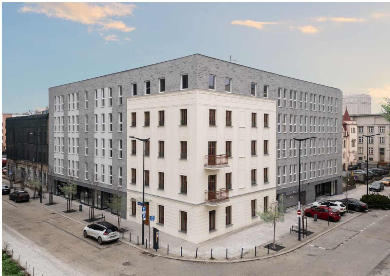
The Rental Housing Fund, Łódź, ul. Składowa, 64 apartments
