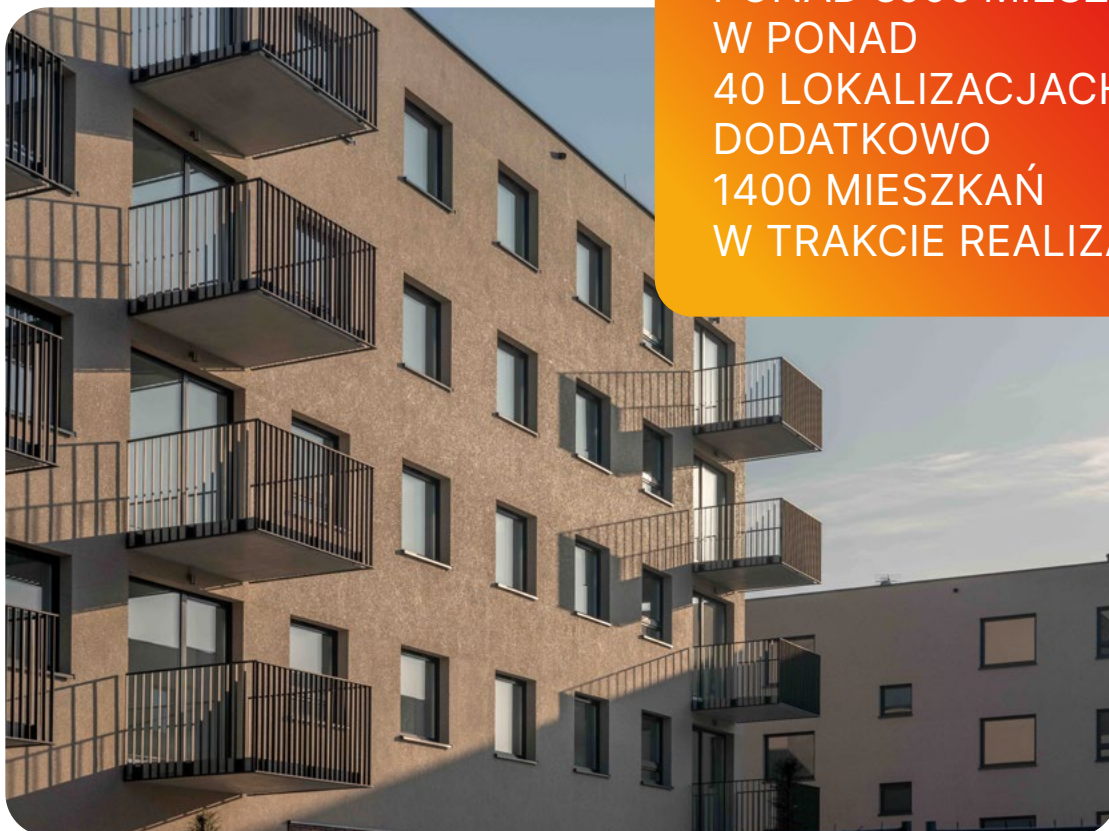
Osiedle PFR Nieruchomości przy ul. Korczaka w Katowicach (fot. materiały własne)
