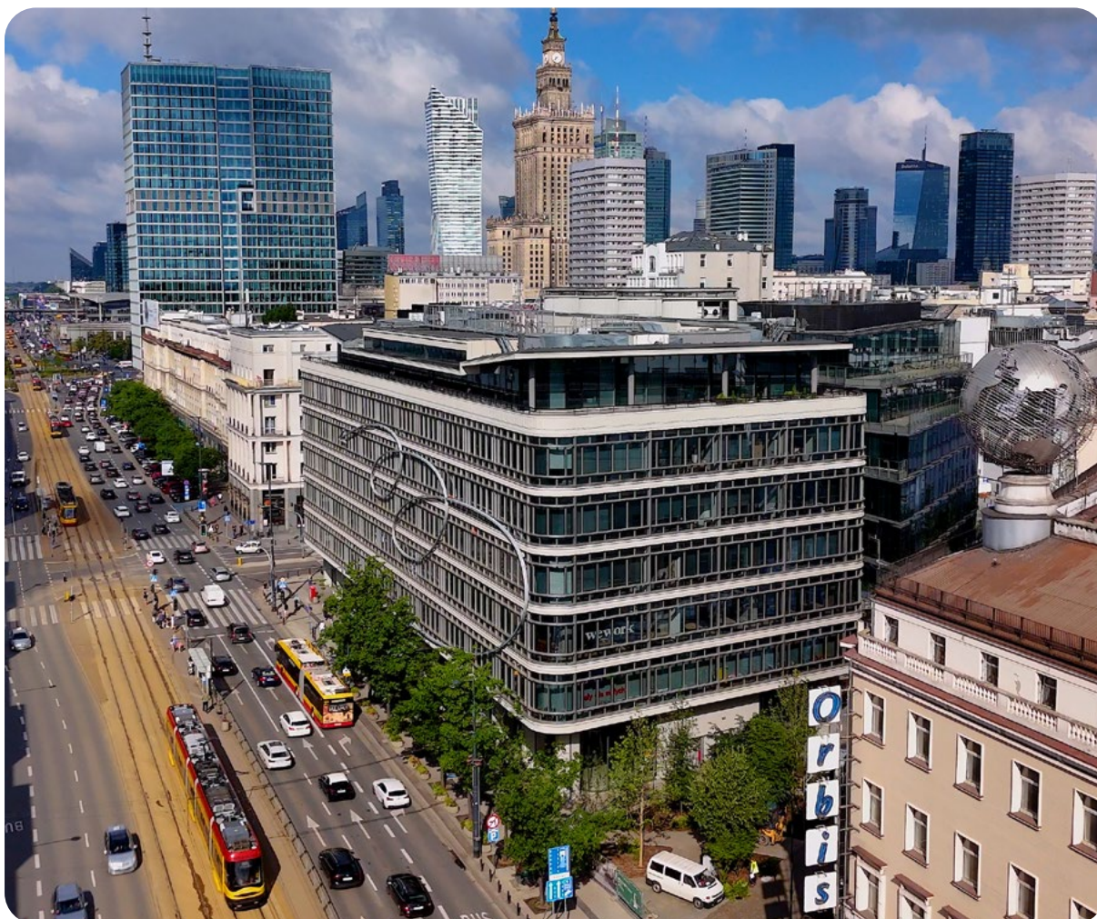
Siedziba GK PFR przy ul. Kruczej 50 w Warszawie (fot. materiały własne)
